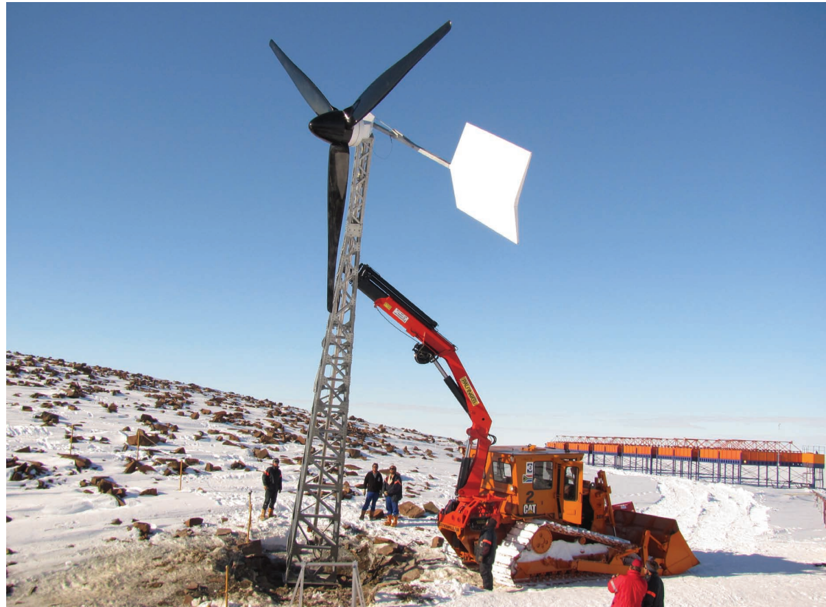
Die oprigting van 'n windturbine van die US se Fakulteit Ingenieurswese vroeër vanjaar by die SA basis in Antarktika. Die lesse wat op die yskontinent geleer word, kan tot toepaslike tegnologie vir Afrika lei, waar uiterste klimaatstoestande eweneens uitdagings skep.
